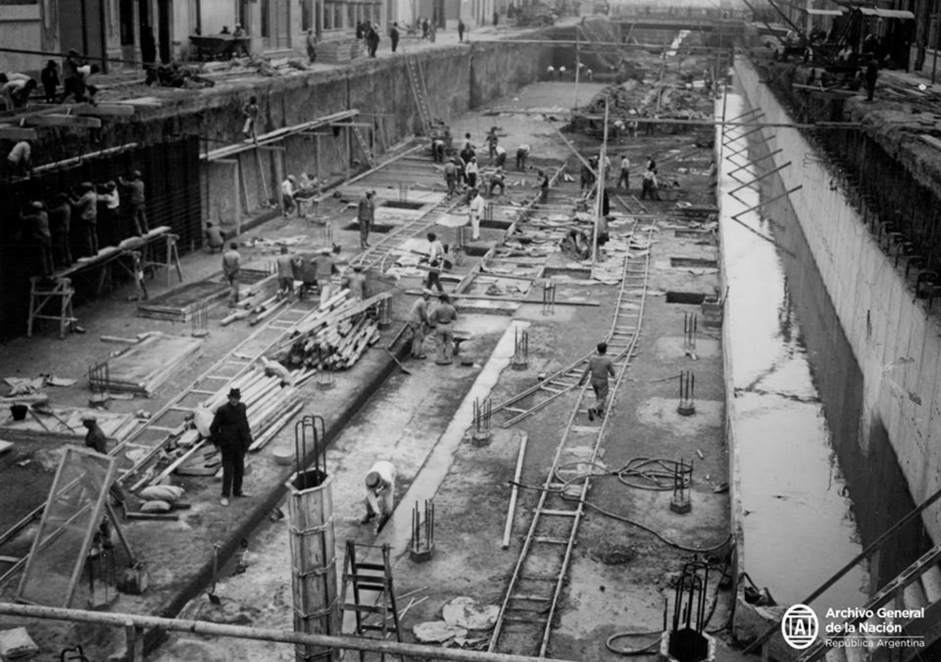
Arroyo Maldonado transformado en una infraestructura subterránea de desagüe, Buenos Aires, 1930's
